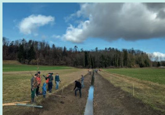
Das Katzenstiegbächli wird bepflanzt.
