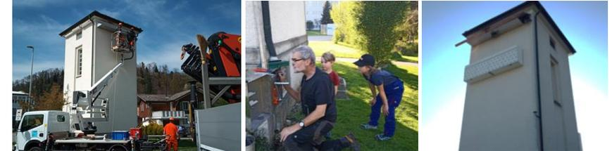
Montage des Vordaches an der Trafostation und montieren des Kastens
